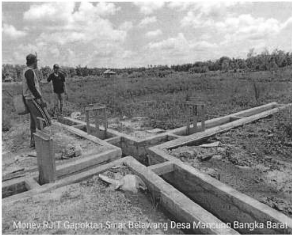
Gb. 5 Rehabilitasi pintu air
