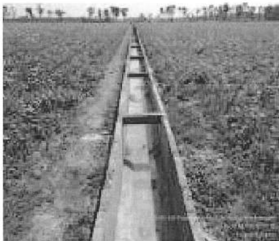
Gb. 4 Jaringan irigasi ( ferrocement ) di lahan rawa
