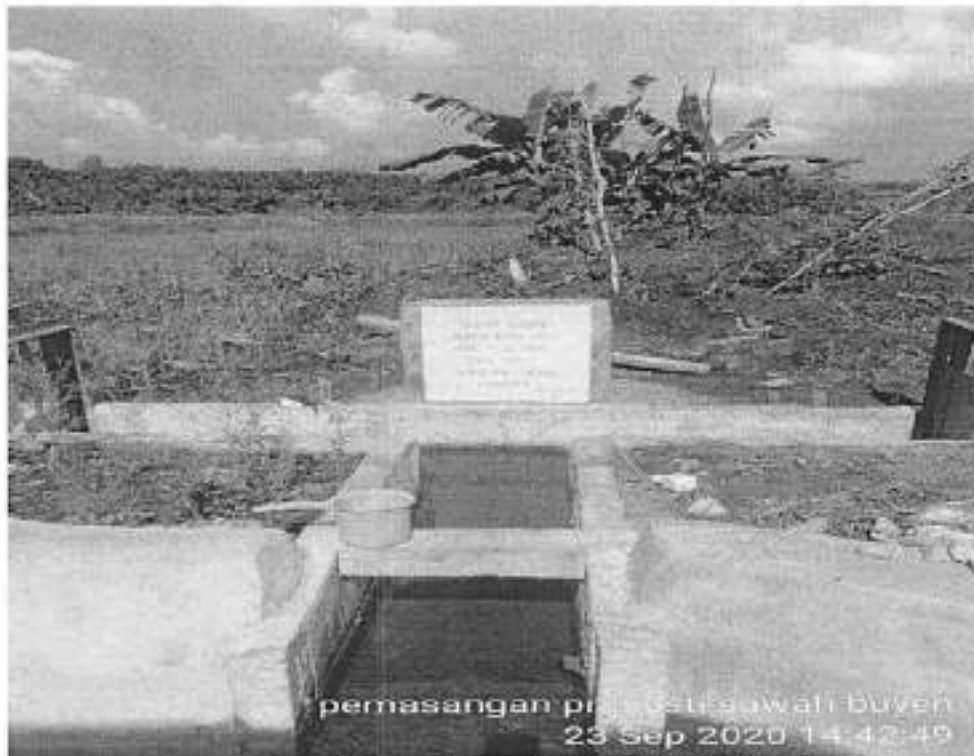
Gb. 2 Rehabilitasi boks bagi
