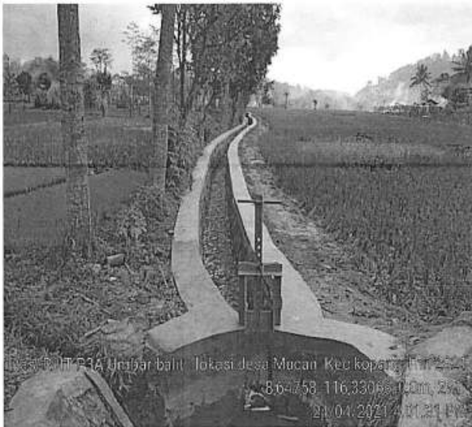
Gb. 8 Jaringan irigasi desa dilengkapi pintu air
