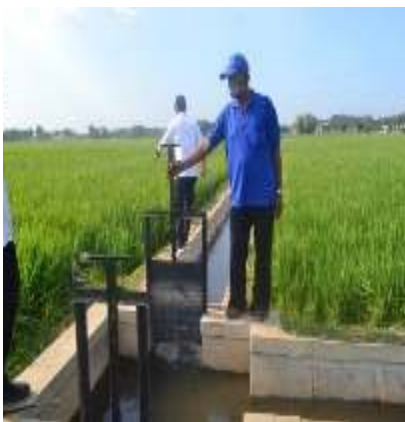
Gb. 5 Rehabilitasi pintu air
