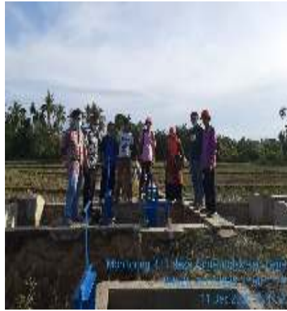
Gb. 2 Rehabilitasi boks bagi
