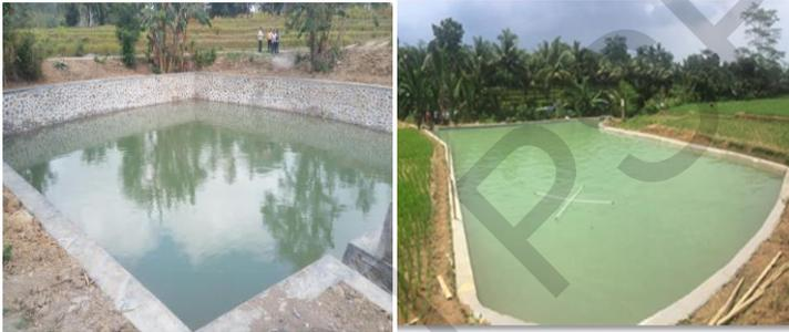
**Gambar 1. Embung dengan pasangan batu kali**
