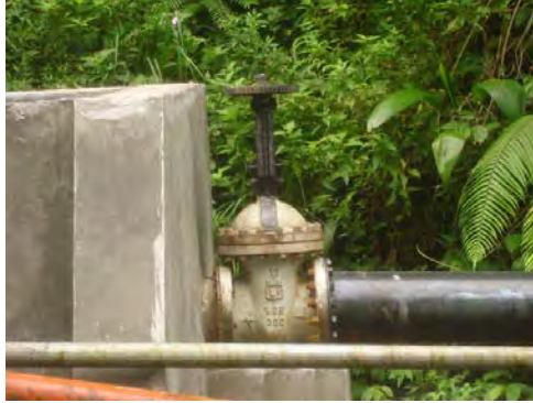
Gambar Bangunan Penangkap Air dan Kran Pengatur
