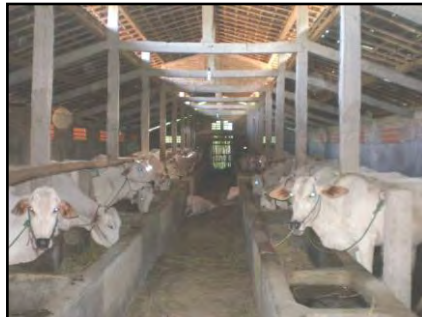
Gambar 4. Contoh bangunan kandang komunal
