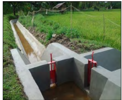
Pintu Air dan Boks Bagi Kabupaten Sanggau
