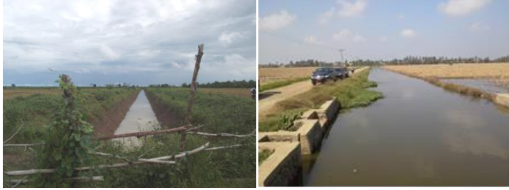
Long Storage dengan pintu air
