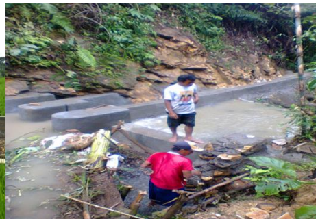
Jaringan Irigasi (bendung) Kabupaten Lebak
