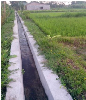
Jaringan Irigasi (pasangan batu kali) Kabupaten Sleman
