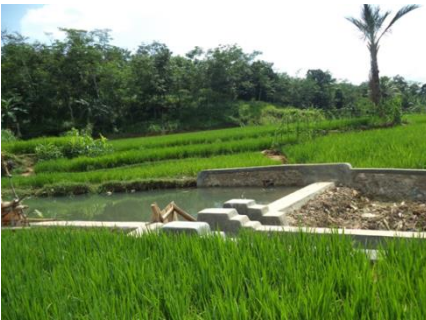
Jaringan Irigasi (bendung) Kabupaten Lebak
