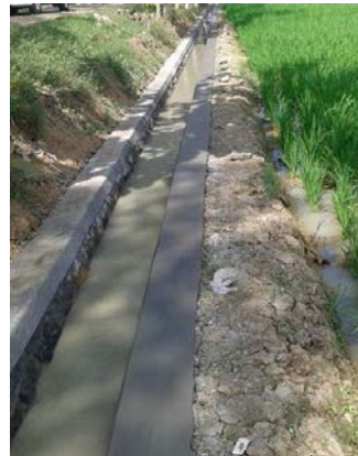
Jaringan Irigasi (pasangan batu kali) Kabupaten Cilacap
