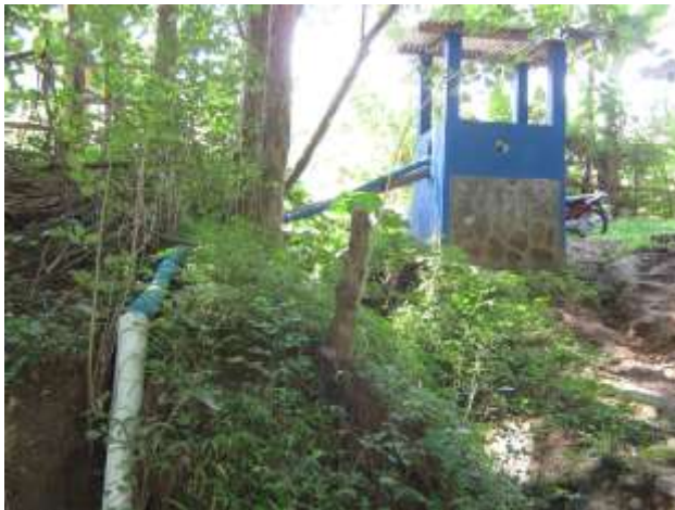
Gambar 2. Pipa Intake Ke Pompa
