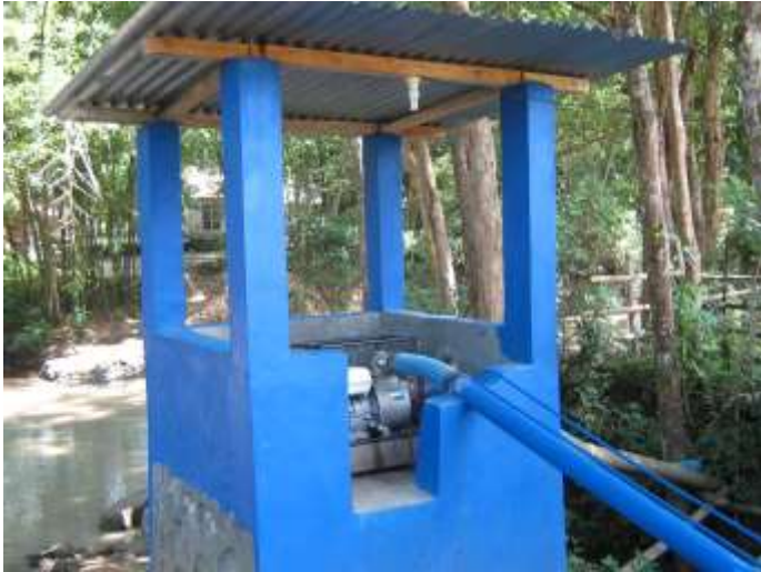
Gambar 3. Rumah Pompa dan Pompa Air
