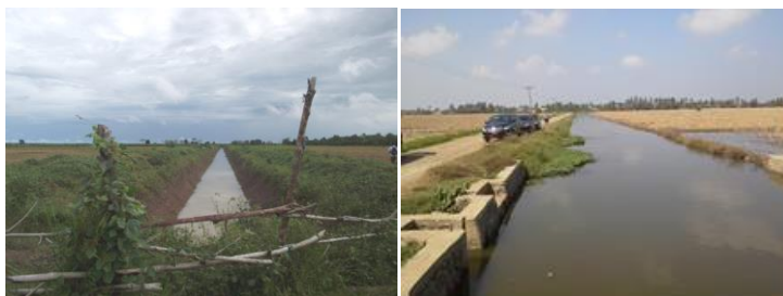
Long Storage dengan pintu air
