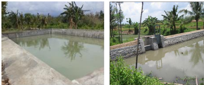
Embung dengan pasangan batu kali
