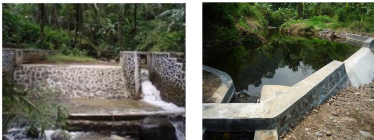
Bangunan Dam Parit beserta bangunan kelengkapannya
