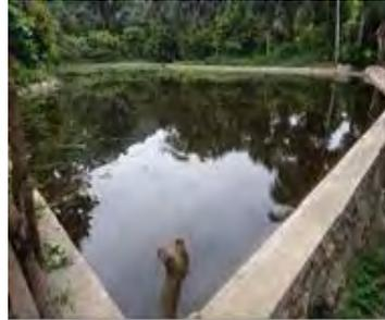
**Gambar 1. Embung dengan pasangan batu kali**
