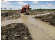
Pembuatan Saluran Pembuang Untuk
