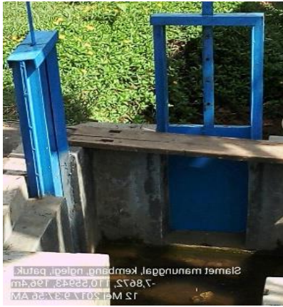
Gb. 5 Rehabilitasi pintu air
