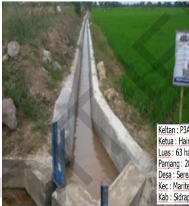
Gb. 7 Jaringan irigasi tersier dilengkapi pintu air
