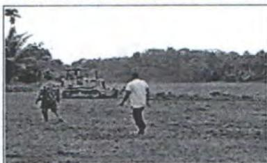
Pengikisan, pengusuran dan penimbunan tanah (*cut and fill*)
