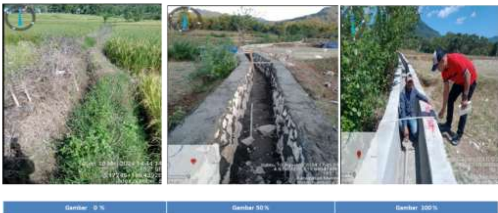
Gambar 22. Dokumentasi Kegiatan Rehabilitasi Jaringan Irigasi Tersier
